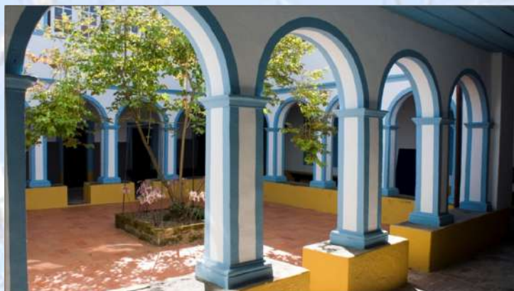
Figura 1: Convento de Santa Maria da Caridade (Salgueiro 2019)
